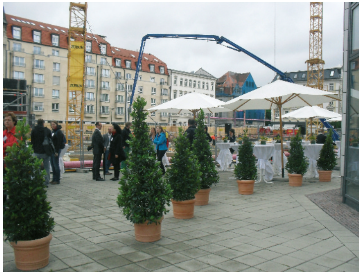
Die Baustelle am Wintergartenhochhaus am Tag der Grundsteinlegung
